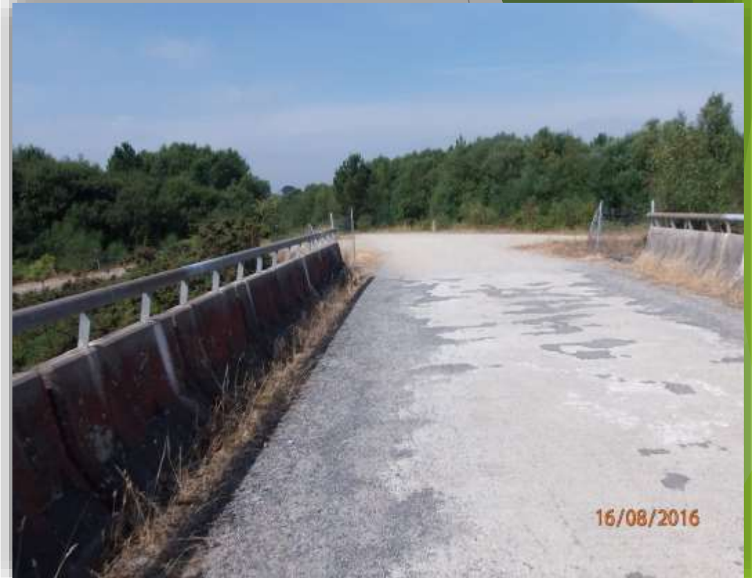
Puente sobre la autovía 1
