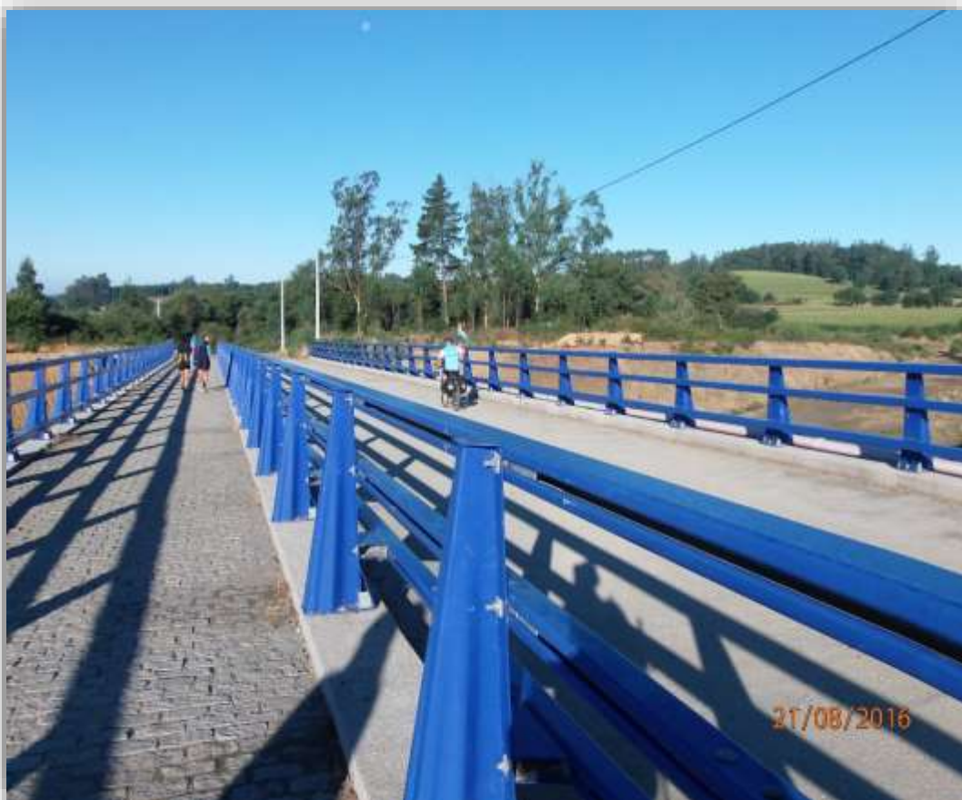
Puente sobre la autovía
