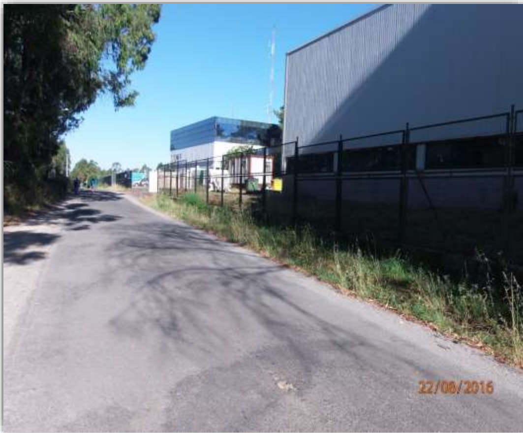
Instalaciones Televisión de Galicia
