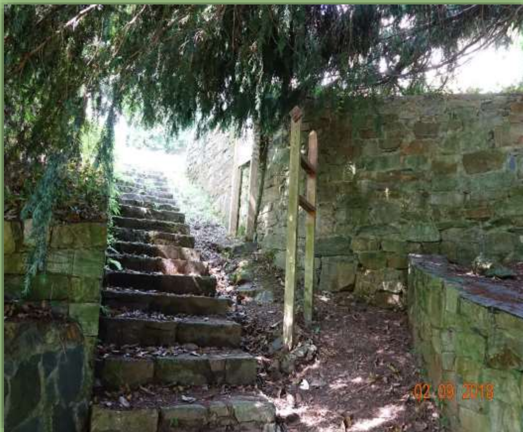
Escalera de bajada y subida.
