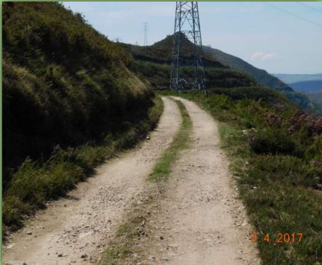
La torre de distribución de electricidad.
