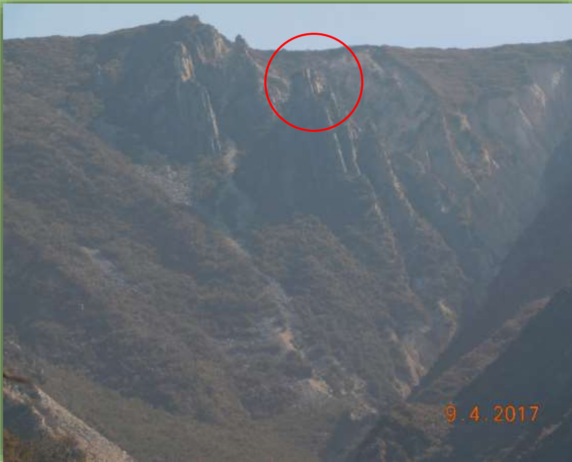
Restos del desmonte vistos desde la parte inferior.
