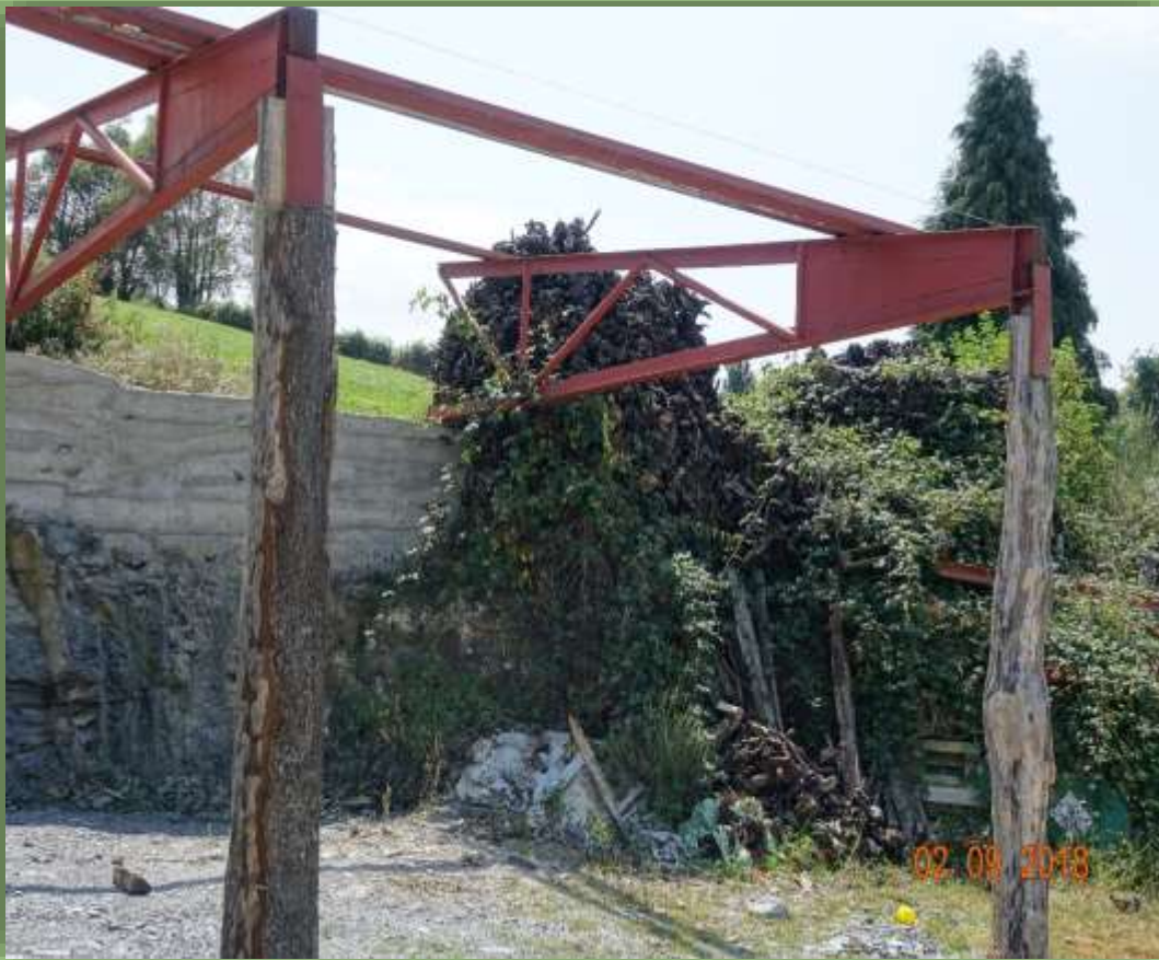
Pequeña nave en construcción.
