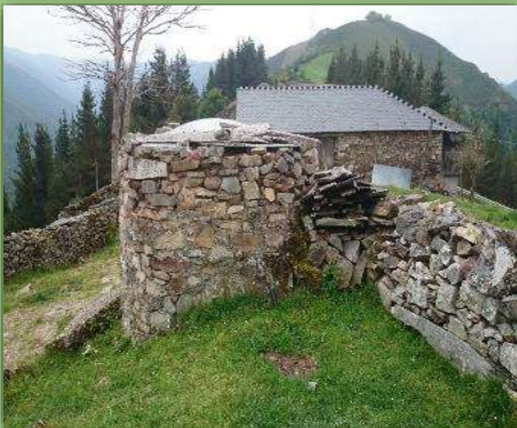
Hospital de Montefurado Muro de protección.
